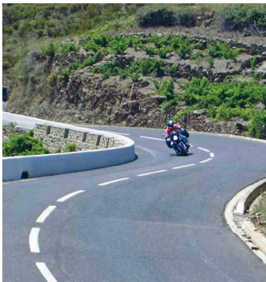
Kjør E 15 sørover fra Perpignan. Ta av ved Le Boulou og kjør vestover mot Andorra. Etter hvert åpner svinghimmelen på N152/N260 seg.
