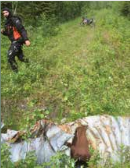
En ødelagt rør med et dypt hull. Det kunne skapt trøbbel, men Arne ga gass og skvatt over og fikk varslet oss som kom bak.
