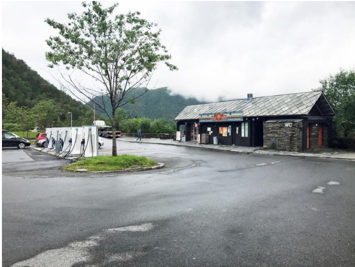
Kommersiell virksomhet ved Trengereid E16 Foto: Statens vegvesen
